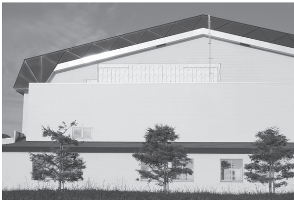
西側外壁等補修箇所
