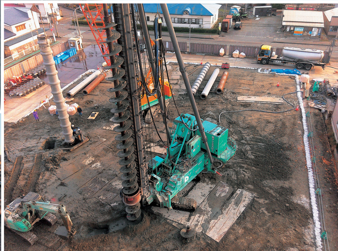
33カ所をオーガー掘削（ドリルで地面に穴を空ける）し、連結した3本の基礎杭（長さ約30m）を埋込みする様子
