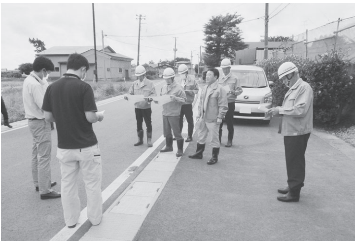
町道小池線道路舗装修繕工事箇所
