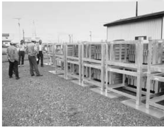
防雪柵収納ラック設置工事
