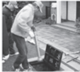
消火栓に差し込む
