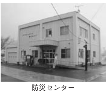
防災センター
