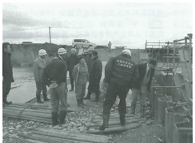
アオコ遡上防止オイルフェンス工事現場視察
