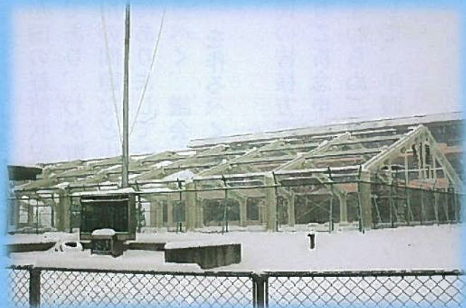
鉄骨と更衣棟の塗装工事が完了したB & Gプール
