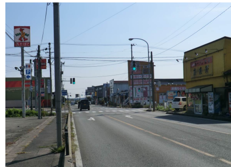
国道7号沿道の状況
