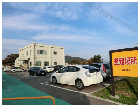
防災センターの状況
