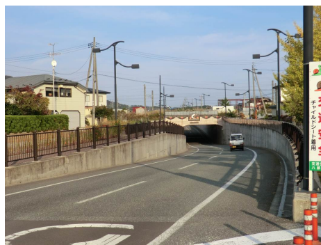
町道中央線の状況
