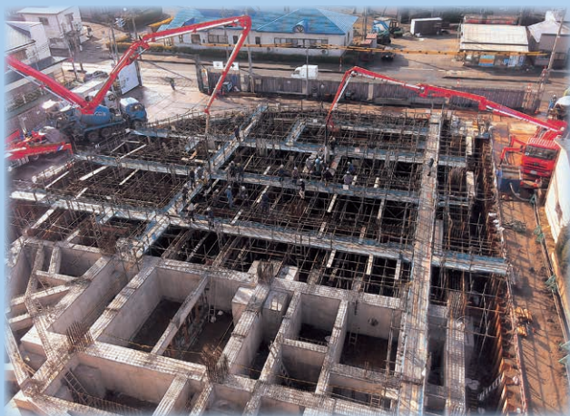
③掘削・基礎工事 (基礎コンクリート打設)
