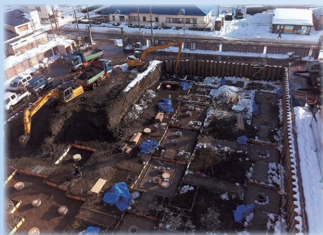
②掘削・基礎工事 (掘削)
