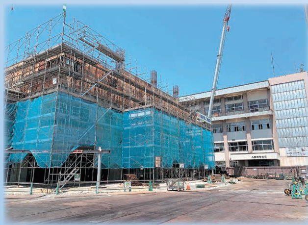
④地上部躯体工事 (3F壁・柱型枠工事)
