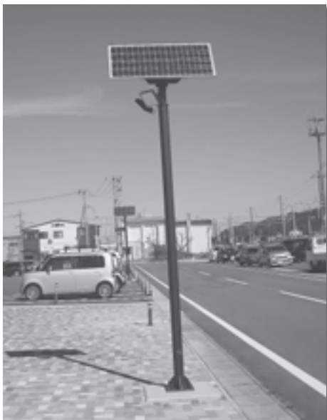
街路灯設置工事
