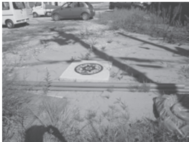
防火水槽移設工事
