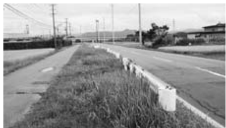
町道及び自歩道 (川崎地区内)
