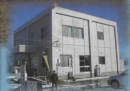
防災センター改修
