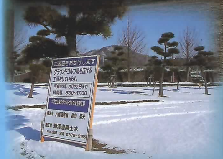
グラウンドゴルフ場拡張工事
