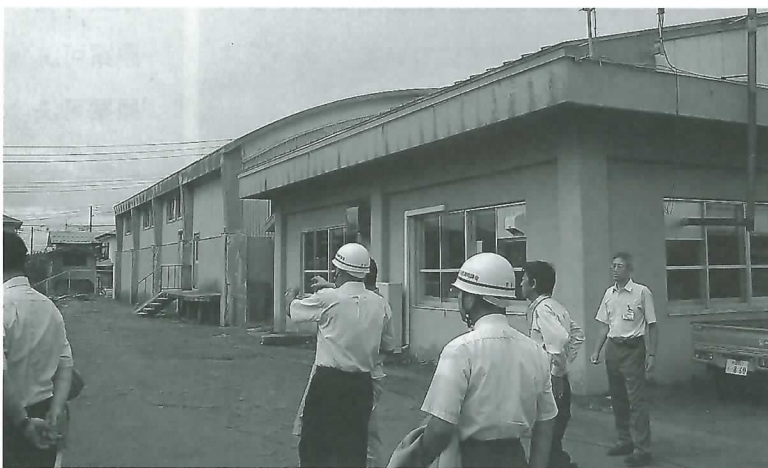
急速濾過池の濾材交換現場を視察
