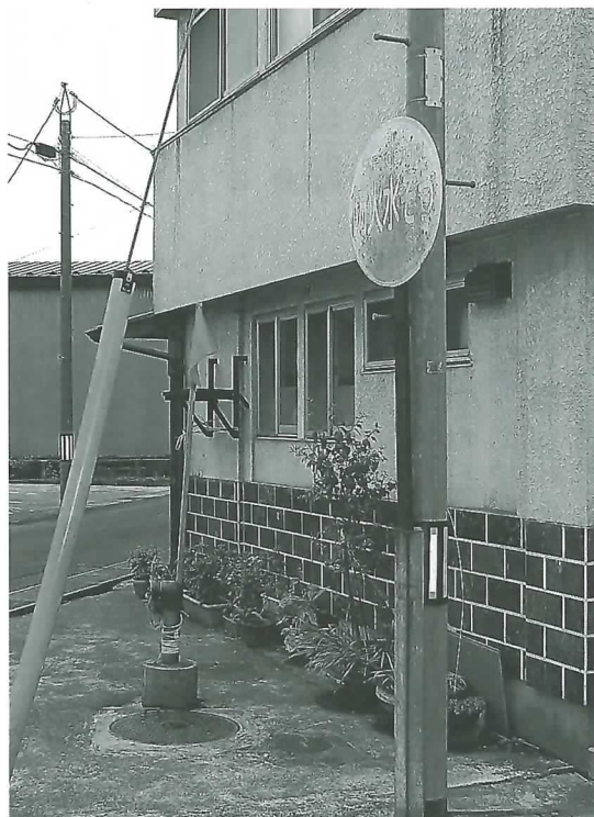
3区町内の防火水そうと標識
