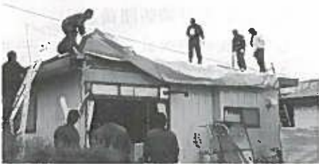
町消防団による復旧作業
