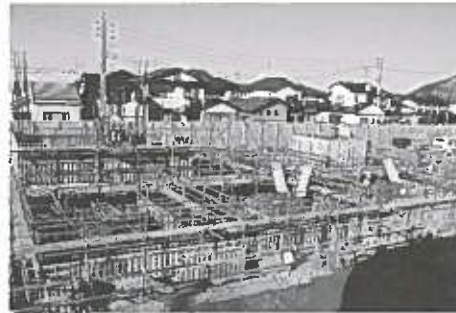
工事現場（11月10日撮影）
