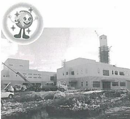
八郎湖周辺清掃事務組合ごみ処理施設工事現場（11月19日撮影）
