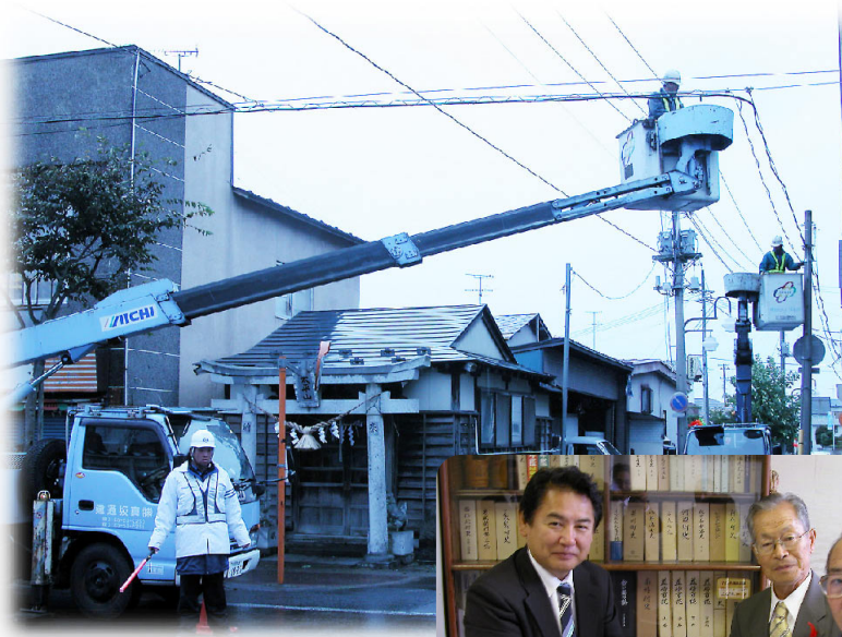
光ケーブル工事の様子 (一日市地区)
