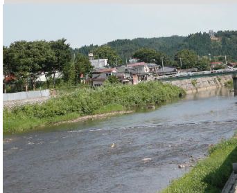
ダ ム 放 流 後 の 五 城 目 町 の 馬 城 橋 付 近
