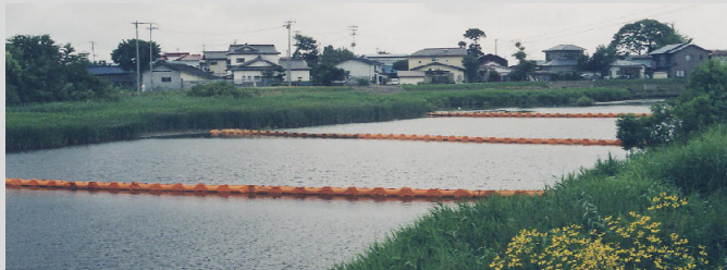
オイルフェンスがはられた馬場目川(取水口西側3連)
