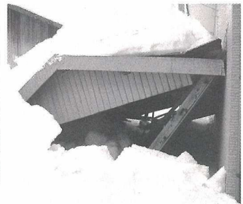
雪の重さで小屋が倒壊
