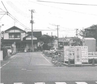
▲中央線工事状況（5月24日撮影）
