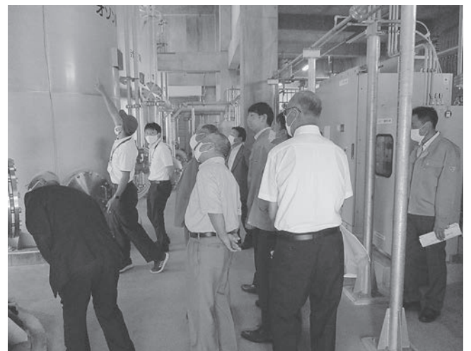
浄水場（現地視察）
