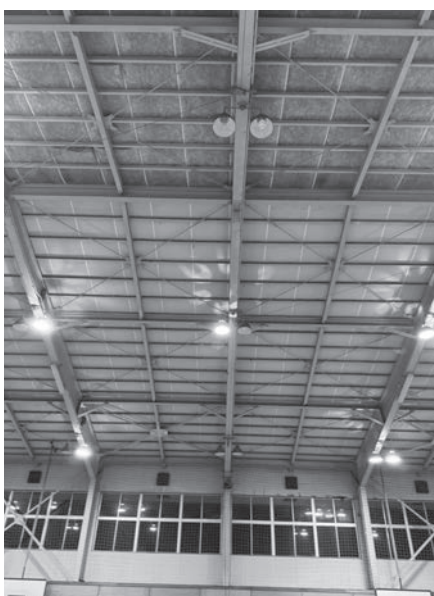
点灯しない照明が増えてきた第二町民体育館
