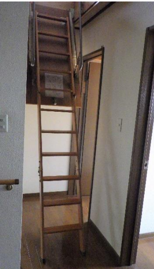
②⑨小屋裏収納-1（梯子）
