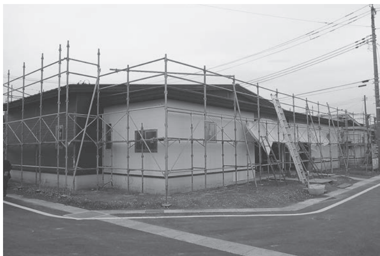
建設中の町営中嶋住宅
