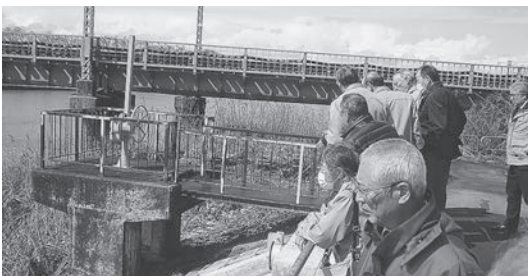
34区内水排水ポンプの設置状況
