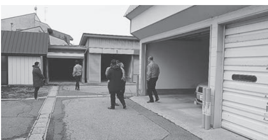
新庁舎建設に伴う北側車庫等解体予定箇所
